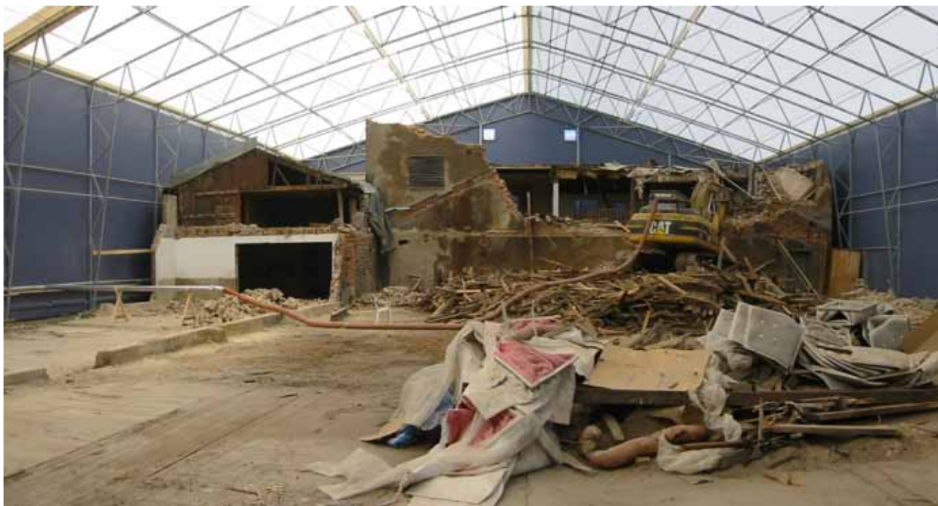
Figur 7.4: Rivning av Cellhallen och Indunstningen i tält 2006
