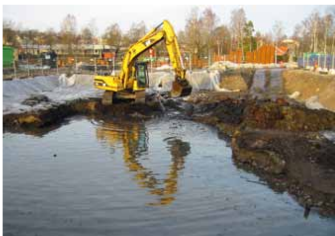
Figur 7.11: Urgrävning av förorenade sediment i stenkistan
