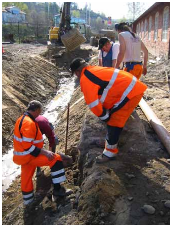
Figur 7.2: Till vänster är den färdiga skyddssponton med slang till pump. Nere till höger anläggs dränering längs Strömgatan och skissen ovanför visar spontens profil
