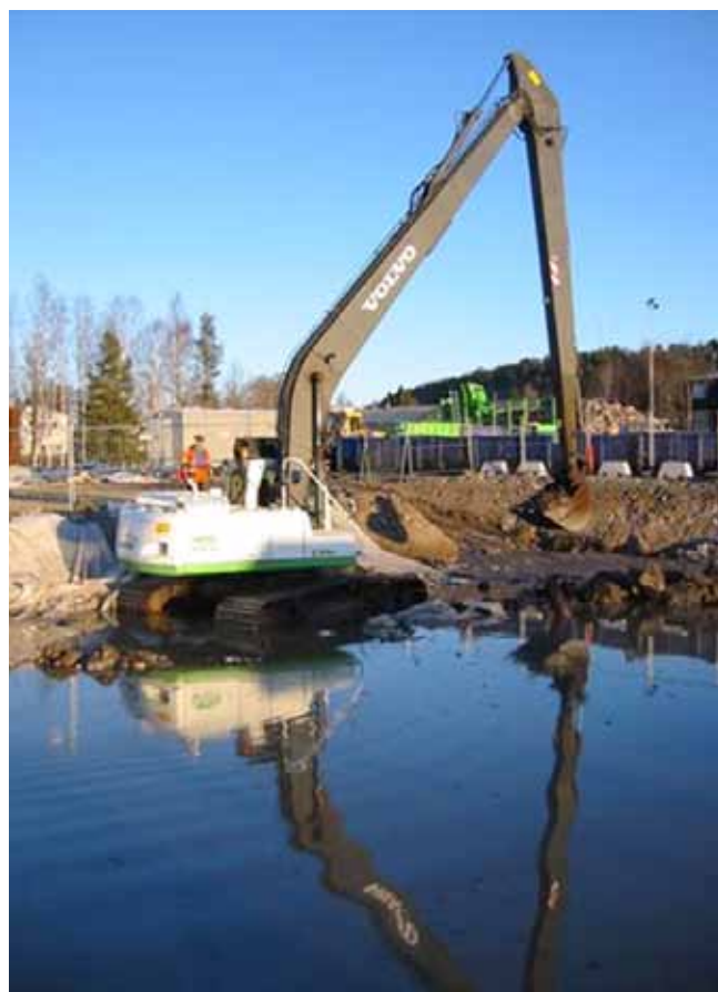
Figur 7.10: Återfyllning av ”stenkistan” med rent utsorterat grovt material
