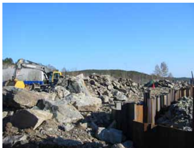
Figur 7.5: Schaktningsarbeten på EKA-tomten 2007/2008
