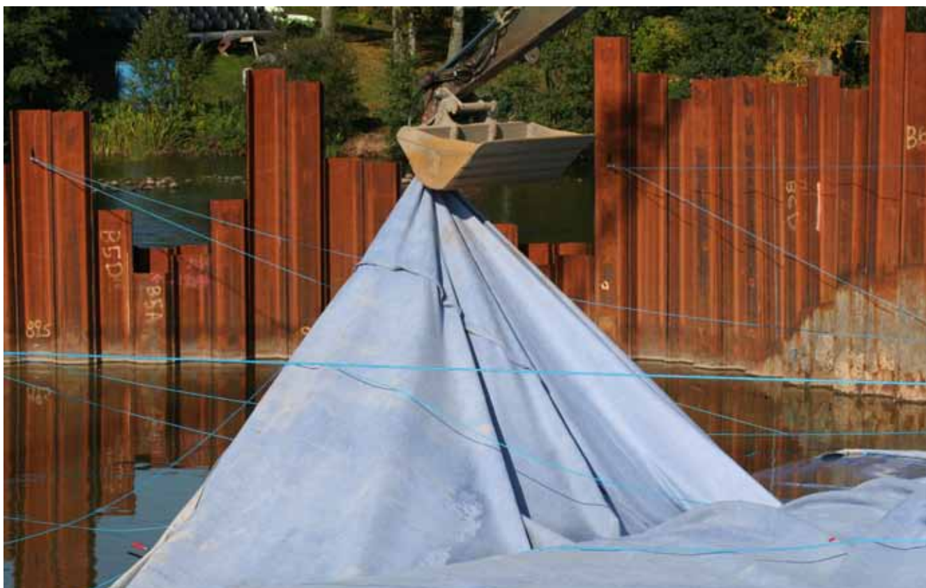
Figur 7.12: Utläggning av geotextil vid udden
