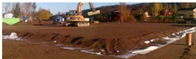
Figur 7.16: Utbredning av skyddstäckning. Geotextilen som syns på bilden fungerar som materialskiljande lager mellan dräneringsskiktet och den slutliga skyddstäckningen
