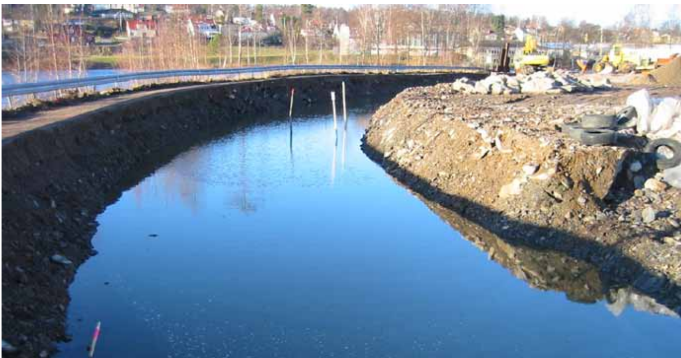
Figur 7.14: Filterschakt som ordningställs för återfyllnad
