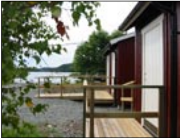
Kanalbåtarnas nya bodar på södra udden. Foto: Sabina Kolodynska
