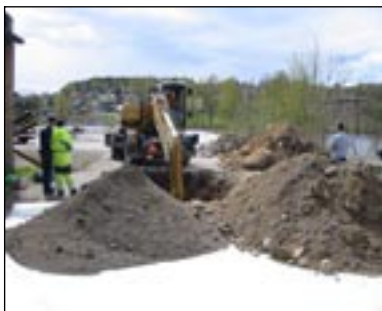
Grävning av provgröp. Foto: Johan Fogelström
