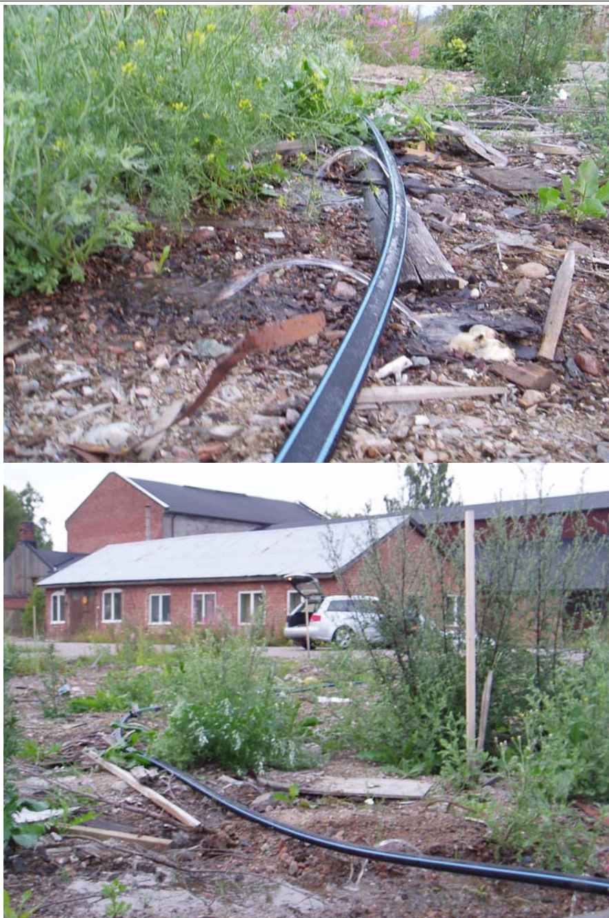
Figur 4 och 5. Det uttagna grundvattnet från 7006 och 301 återinfiltrerades i ett område med relativt låga föroreningshalter.
