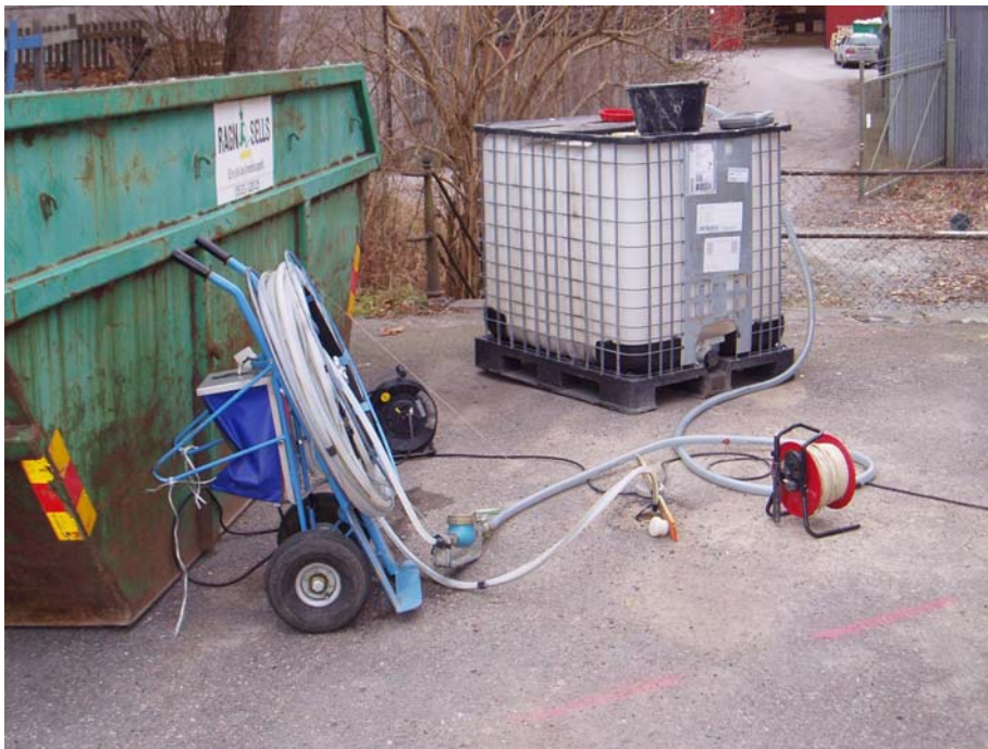
Figur 3. Interferenstest i punkt 7215. Vid försöken samlades pumpvattnet in i syfte att förhindra föroreningsspridning
