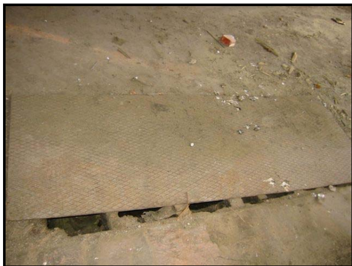
Figur 1 Övertäck smörjoljegrop i BYG B b
