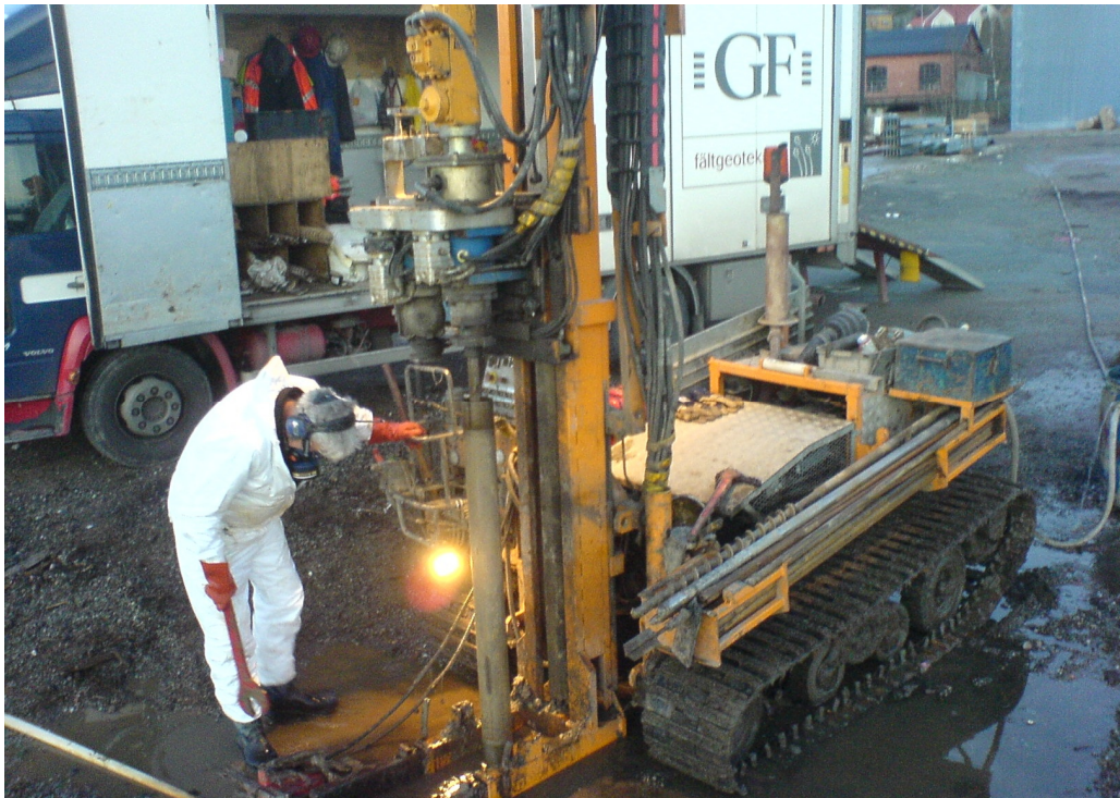
Bild från odex-borring ute på Udden.
