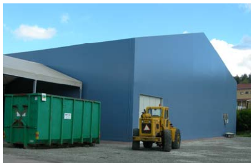
Figur 2. Tältet över cellhallen hade en total volym av 18 000 m 3 och var utrustad med en anläggning för rening av ventilationsluften
