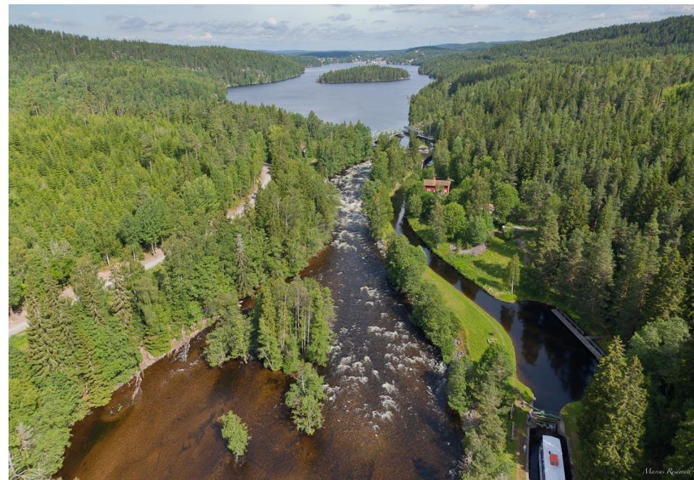
Slusskanalen vid Höljerudsforsarna. Foto av Marcus Reidevall
