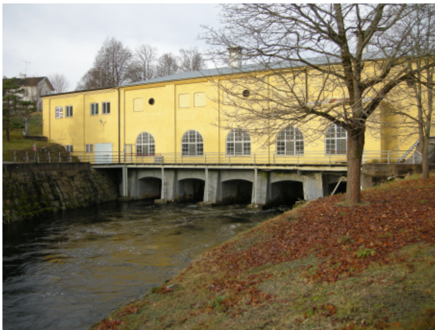
Kraftverksbyggnaden från sydost
