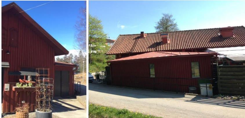
Den tillbyggda köksdelen sett framifrån och från sidan, är anpassad så att taket ansluter under magasinbyggnadens takfot.
