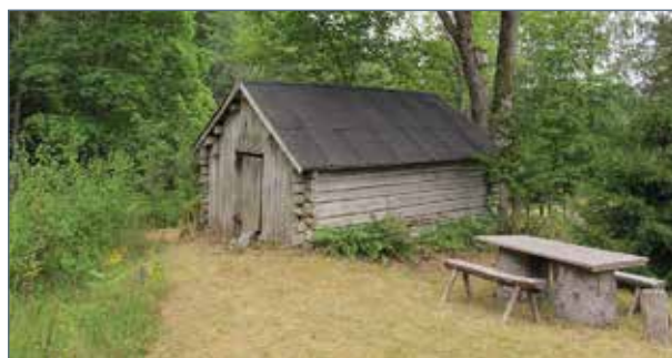
Den timrade boden med tak av Fengersforsplåt.
