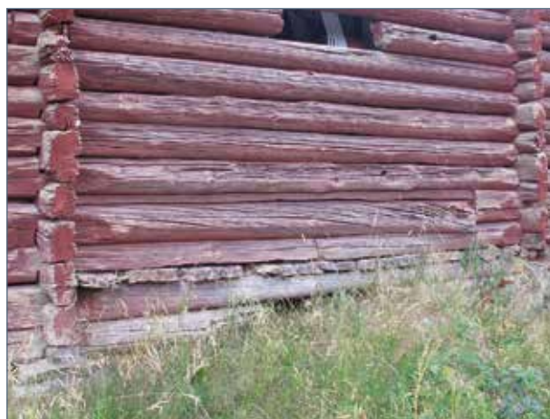
Detalj av ladugården; parlogens tröskgolv sticker ut mellan stockarna i nedre delen av väggen.
