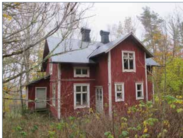
Lärarbostaden tillhörande Ramdalens skola, sedd från väst.
