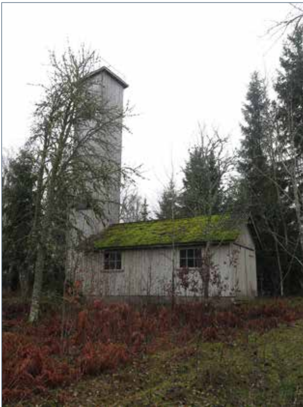
Brandstationen i Ödskölt, sedd från norr.
