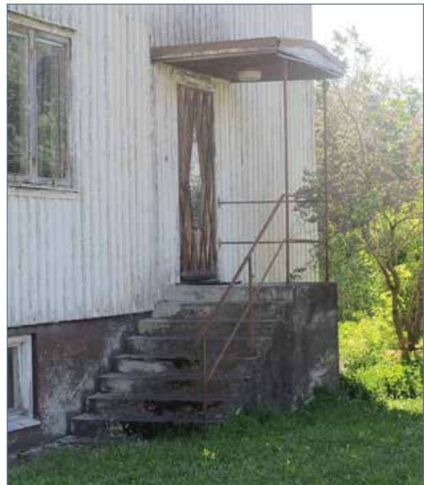
Dekorativt runt fönster och skärmtak över trappan med smäckra smidesräcken är typiskt för den funktionalistiska stilen.
