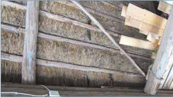
Takkonstruktionen med halmtak inifrån.
