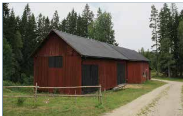
Nya ladugården, sedd söderifrån.
