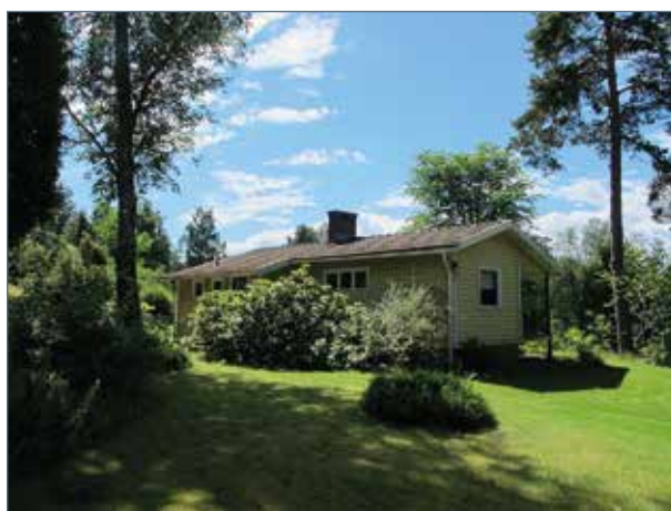
Västkuststugan sedd österifrån.
