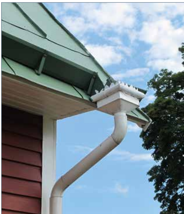
Amerikahuset har omsorgsfullt utförda detaljer i original. Plåttaket avvattnas av smala stuprör med dekorativt utformad vattenkupa.
