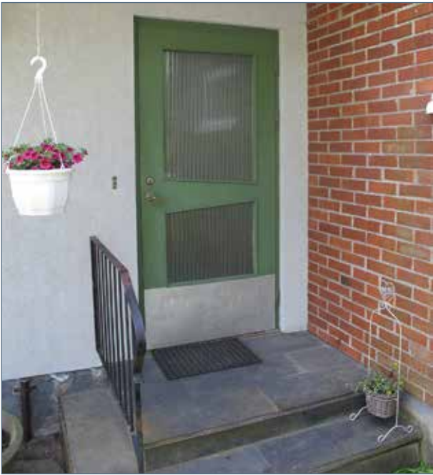
Tidstypisk entré som utformats med omsorg – skiffersatt trappa, smidesräcke och dörr med dekorglas och mässingstrycke.
