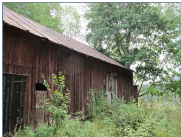
Del av ladugården med takfallet av Fengersforsplåt.
