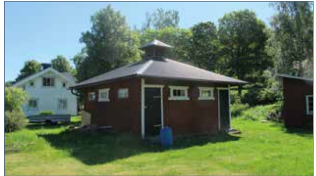
Före detta avträdet med sitt karaktäristiska pyramidformade tak och ventilationshuv.
