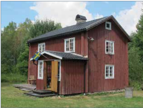
Dalslandsstugan på gården Norra Tomta, sedd från sydväst.
