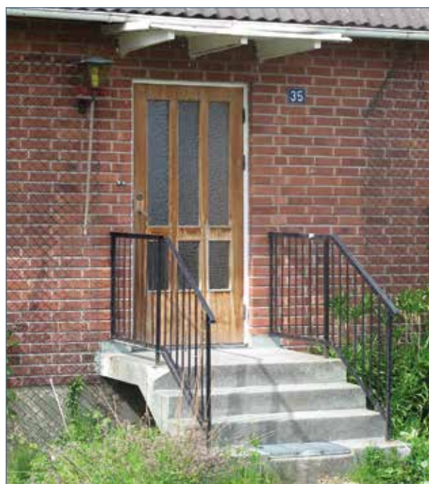
Tidstypiskt dörrparti med betongtrappa, smidesrücken och skärmtak.
