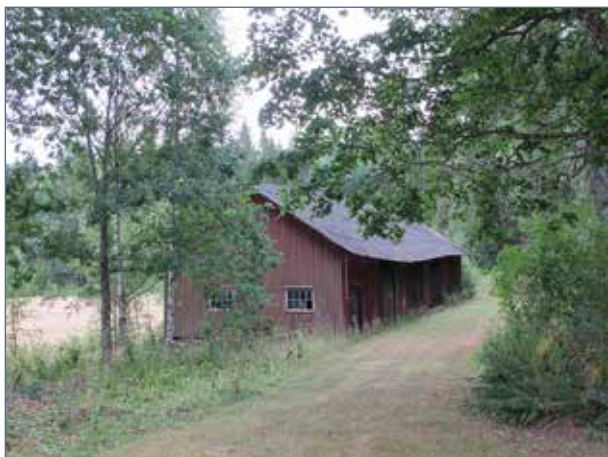
Ladugården med takfall av Fengersforsplåt, sedd norrifrån.
