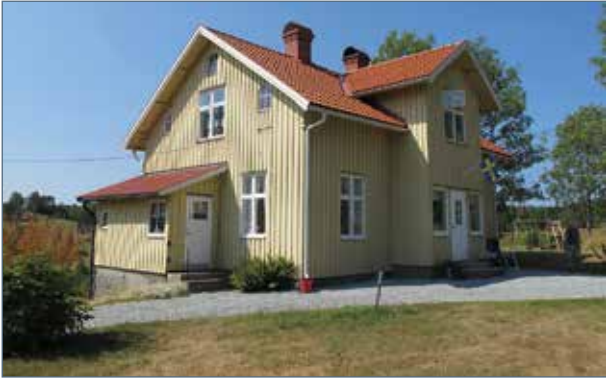
Bostadshuset på fastigheten Gullungebyn 1:5.
