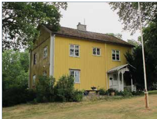
Dalslandsstugan på fastigheten Huken 1:2, västerifrån.
