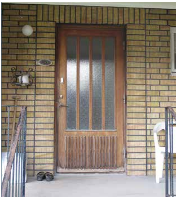
Tidstypiskt dörrparti med dekorglas och karosspanel längst ned.
