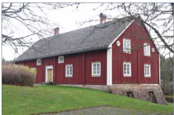
Engelska byggnaden (11) sedd från nordväst.
