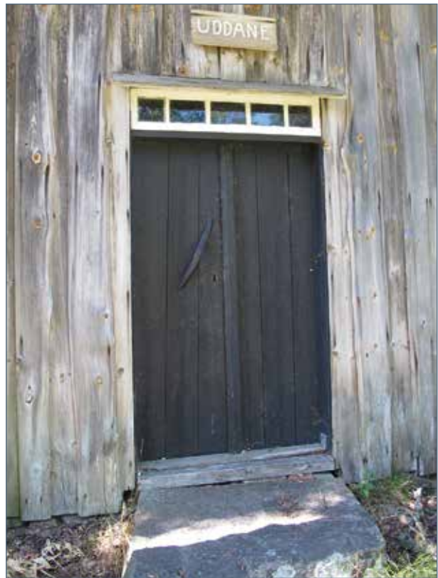
Stugans pardörrar av stående plank med överljus.
