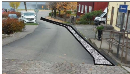
Makadamdike längs Floragatan. Diket utgör ett lågstråk för skyfall och bidrar med viss fördröjning och rening och eventuellt infiltration.
