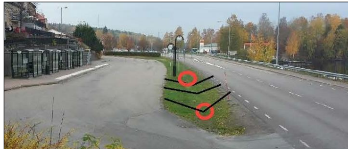
Befintligt dike vid bussterminalen som kan fördjupas/breddas.
