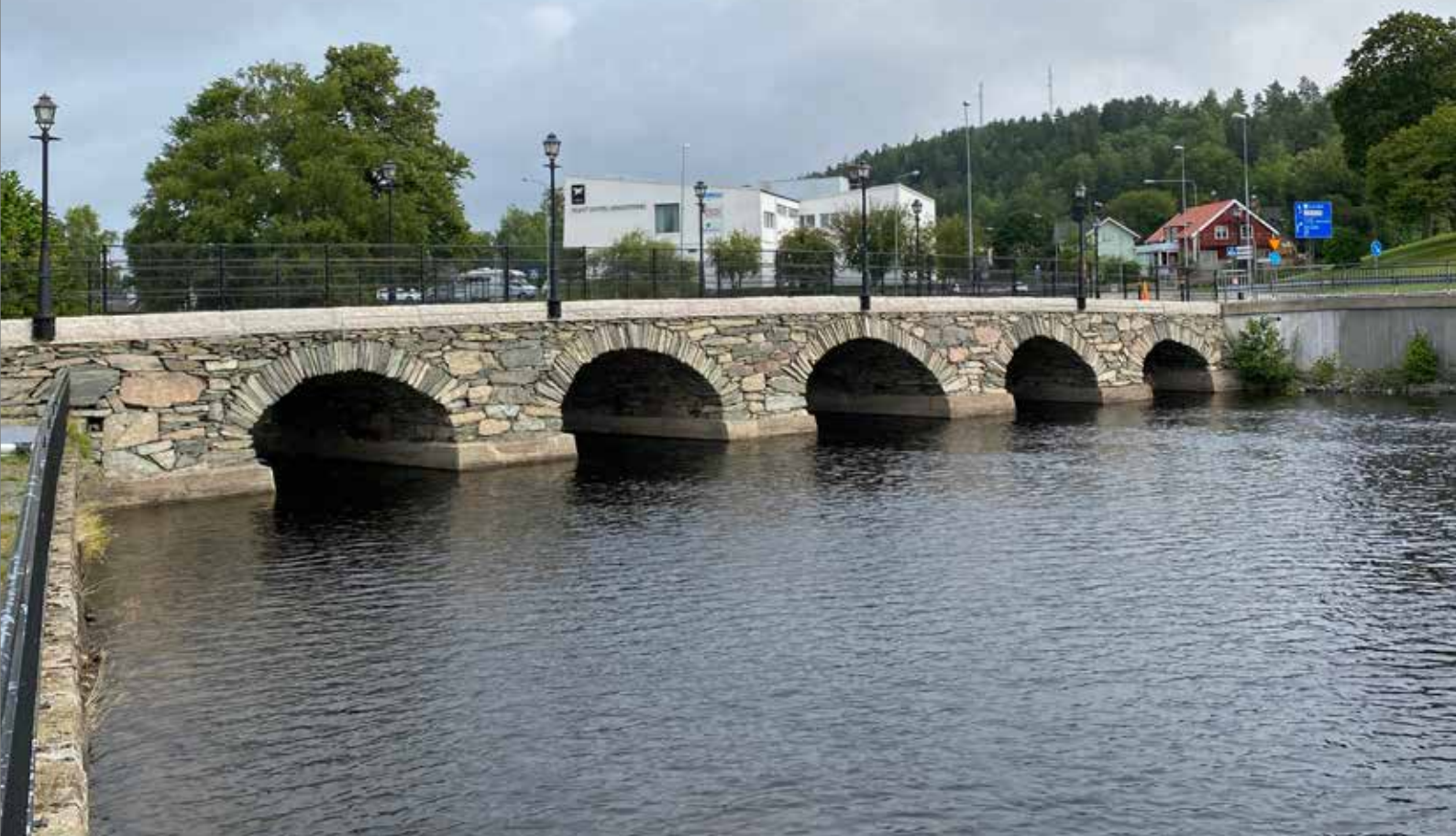
Gamla Strömbron i centrala Bengtsfors kan komma att drabbas i samband med översvämningar och höga vattenflöden.
