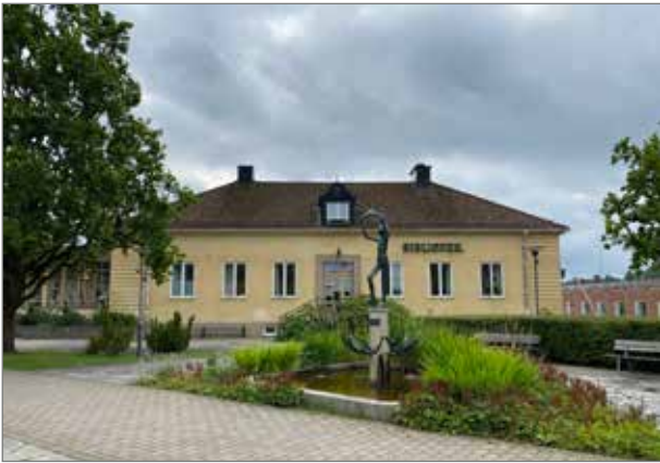
Kommunalhuset i Bengtsfors byggdes 1935. Det är en kulturhistoriskt värdefull byggnad som symboliserar tiden då Bengtsfors var köping, och då stora standardhöjningar gjordes gällande allt från avloppsledningar och polisväsende till gatubelysning och äldreomsorg. Kommunhuset ritades av länsarkitekten Allan Berglund och innehöll ursprungligen bland annat polisstation, brandstation med slangtorn och varmbadhus. Numera ingår det som en del i biblioteket.
